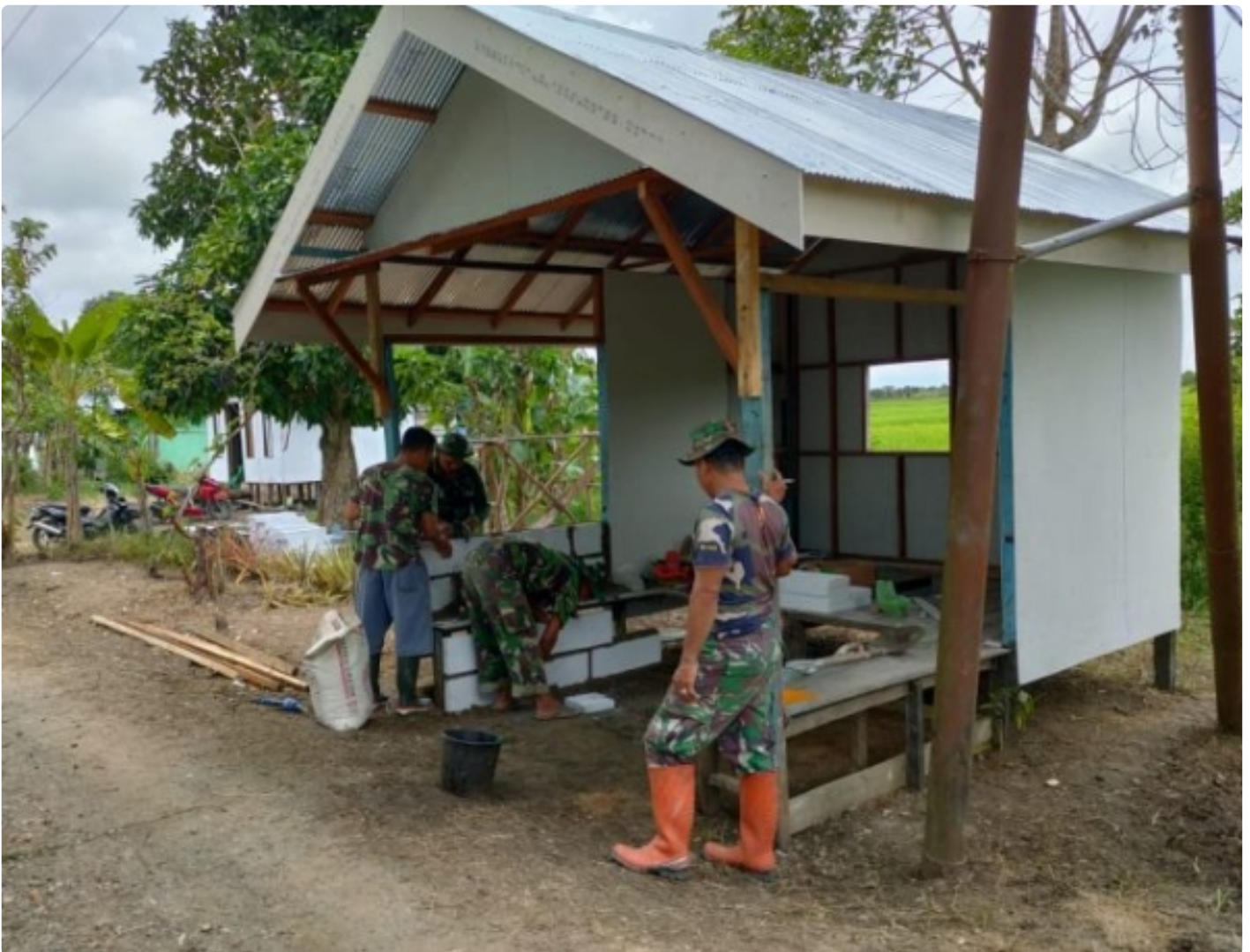
Satgas TMMD ke 113 Kodim 1005/Barito Kuala Bergotong Royong Rampungkan Pos Kampling
