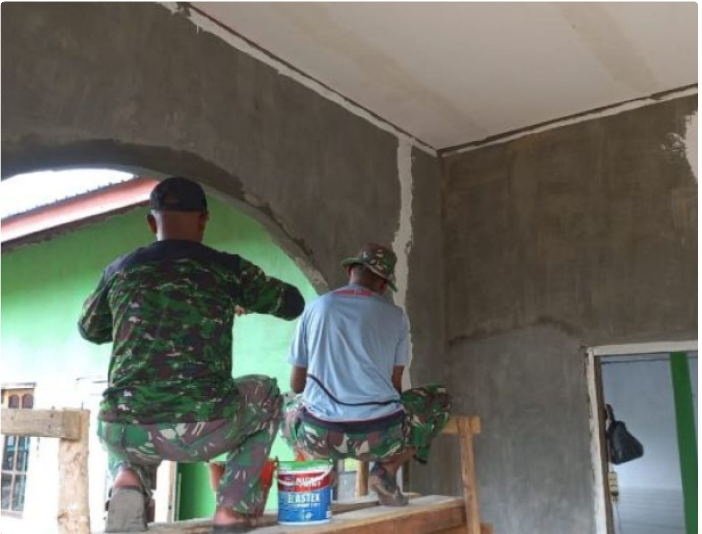
Satgas TMMMD ke-113 Kodim 1005/Barito Kuala Lanjutkan Rehab Masjid
