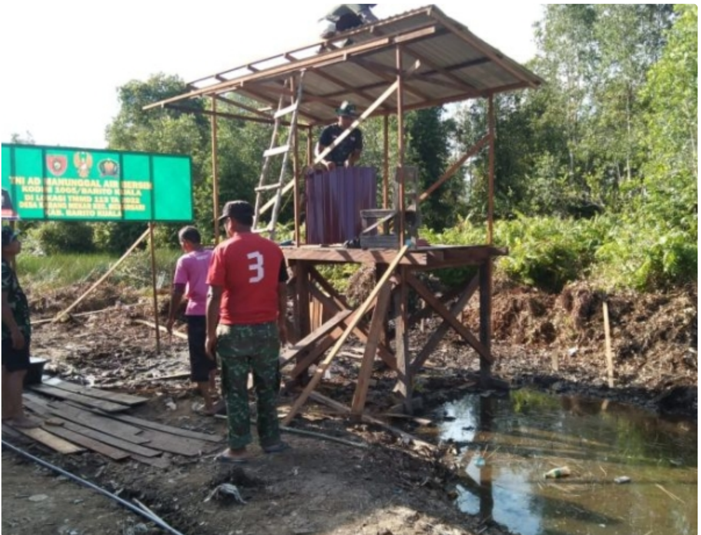
Anggota Satgas TMMMD ke-113 Kodim 1005/Barito Kuala Pasang Atap WC
