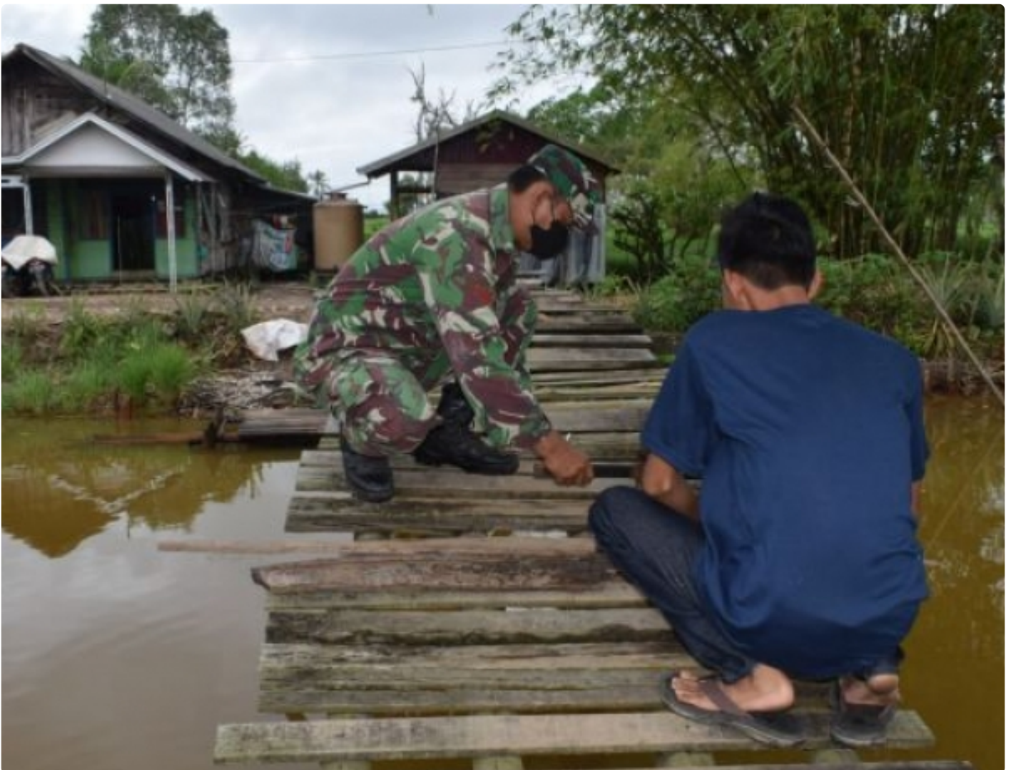
Babinsa Kodim 1005/Barito Kuala Bantu Perbaikan Jembatan
